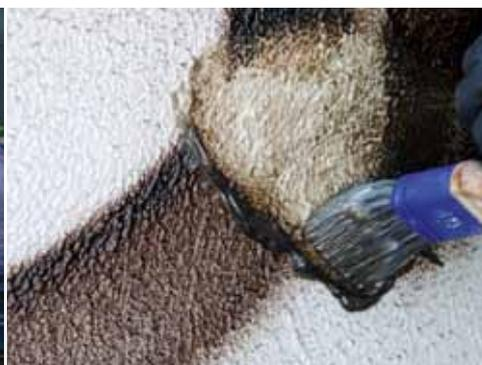
Bitumenentfernung mit Cocopaste, ebenfalls in der Graffiti-entferner Systemtasche enthalten.
