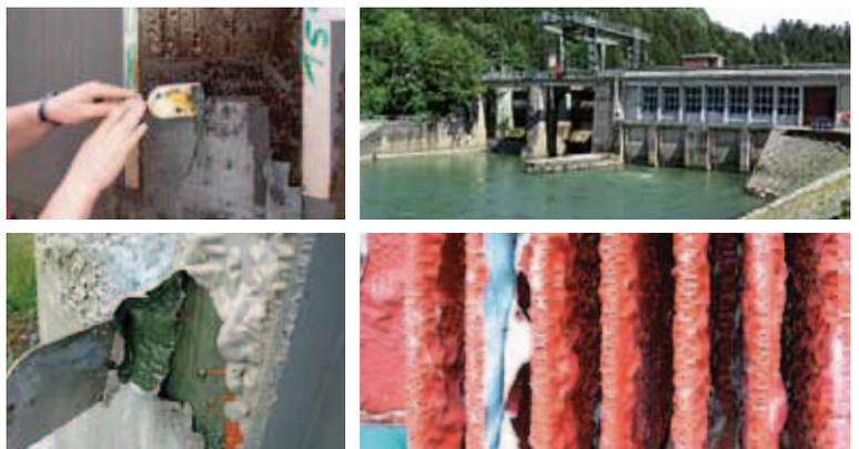
Bilder oben v. l.: Teer-Epoxy-Anstrich (PAK und asbesthaltig), Illerstaustufe
