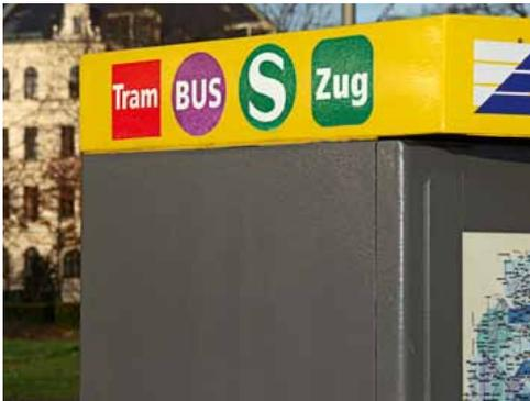
Fahrkartenautomaten wurden mit Eposilan Schutzlack 2K dauerhaft geschützt. Siebdruckfarben werden nicht angelöst.
